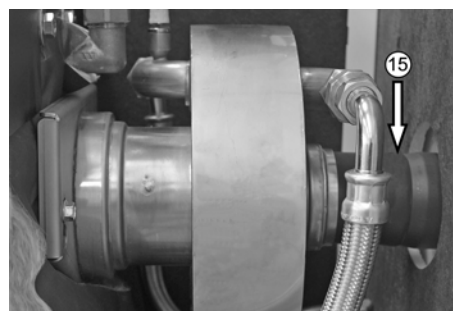
Abb./Fig. 28: Anschluss-Stück ⑮ des Ringrohrwärmetauschers Pièce de raccordement ⑮ de l'échangeur de chaleur à tubes annulaires
