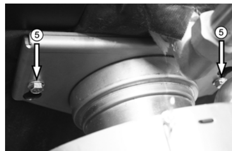
Abb./Fig. 14: Montage des Ringrohrwärmetauschers RWT Montage de l'échangeur de chaleur à tubes annulaires RWT
