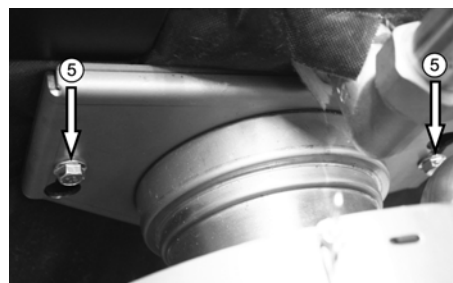
Abb./Fig. 27: Montage des Ringrohrwärmetauschers RWT Montage de l'échangeur de chaleur à tubes annulaires RWT
