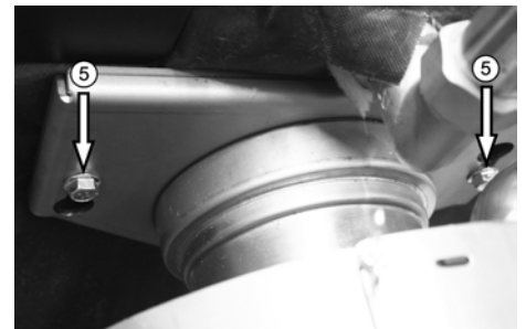
Abb./Fig. 24: Demontage des Ringrohrwärmetauschers RWT Démontage de l'échangeur de chaleur à tubes annulaires RWT
